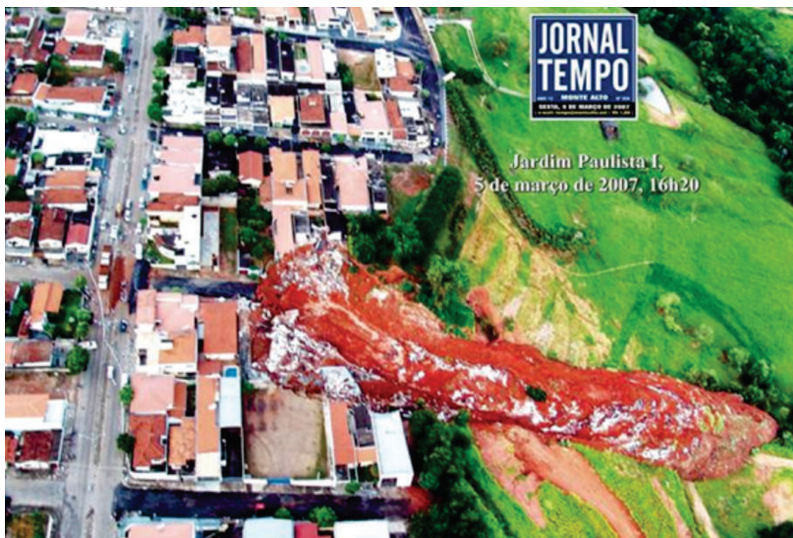
Figura 7. Bossoroca, que teve sua “cabeça” aterrada para receber ocupação urbana, reativada pela concentração de fluxos de água profundos e superficiais. Monte Alto SP. Fonte: Foto Jornal Tempo.
